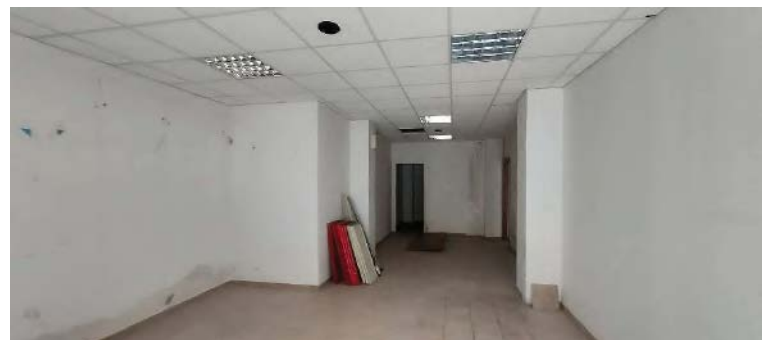
interno locale sx
